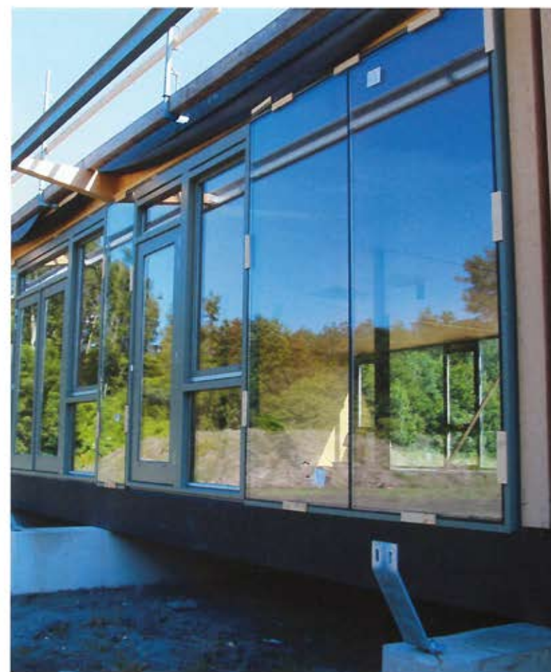
De gevel is door elke bewoner zelf ingevuld aan de hand van een aantal gevelelementen. Tussen de kozijnen is structureel glas aangebracht.
