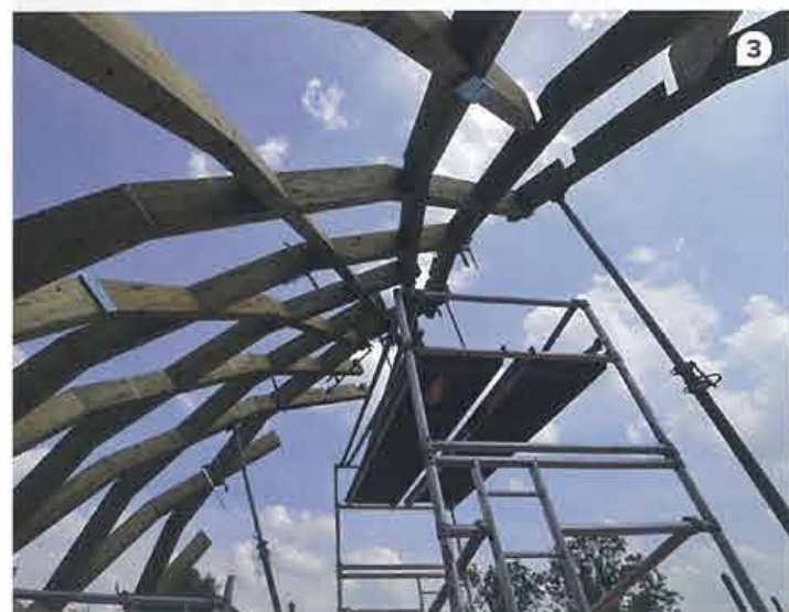
1 // De koepel staat bovenop Kunstfort Asperen. Op de voorgrond de tot taveerne omgebouwde wapenloods. 2 // De koepel dekt de centrale luchtschacht van het gerestaureerde fort af tegen regeninslag. 3 // De koepel is opgebouwd uit geprefabriceerde verduurzaamde elementen, die in het werk donker gebeitst zijn.
