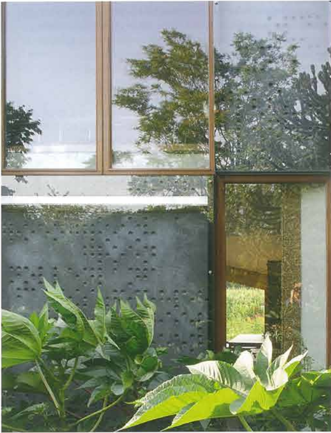
De Trombewanden zijn aan de onderzijde open. Een klep maakt het mogelijk de opgewarmde lucht naar binnen te laten stromen.
