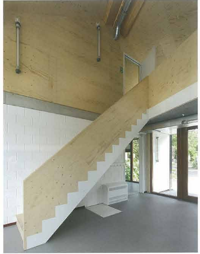
In het gebouw zijn de constructie en de luchtkanalen zoveel mogelijk in het zicht gelaten.
