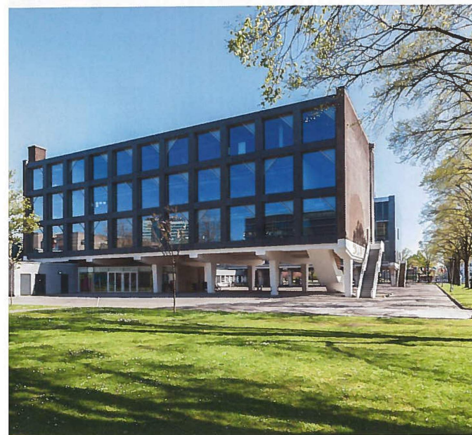
De noordgevel is in basis gelijk aan de zuidgevel, maar dan zonder de zonwering van accoya-hout.
