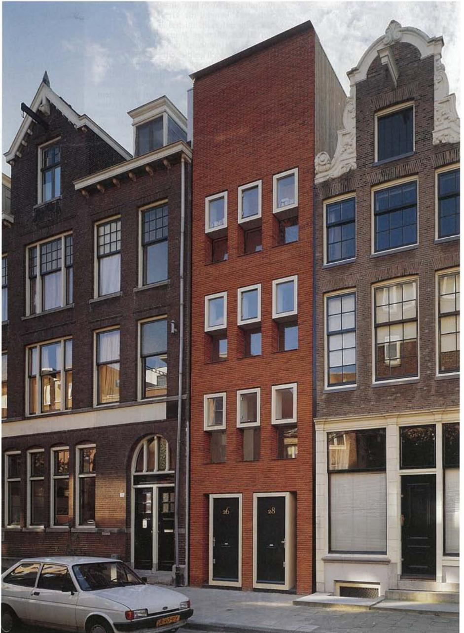
Beim zweiten Neubau am Hoogte Kadijk schräg gegenüber entschieden sich die Architekten für eine „Doppelung“ der Fassade. Die Grundrisse der Häuser mit größerer Gebäudetiefe sind völlig anders konzipiert. In den Obergeschossen sind spiegelsymmetrisch zwei Wohnungen mit einem durchgehenden Wohnraum und zentraler Küchenzeile angeordnet. Grundrisse Erd- und Regelgeschoß im Maßstab 1:333
