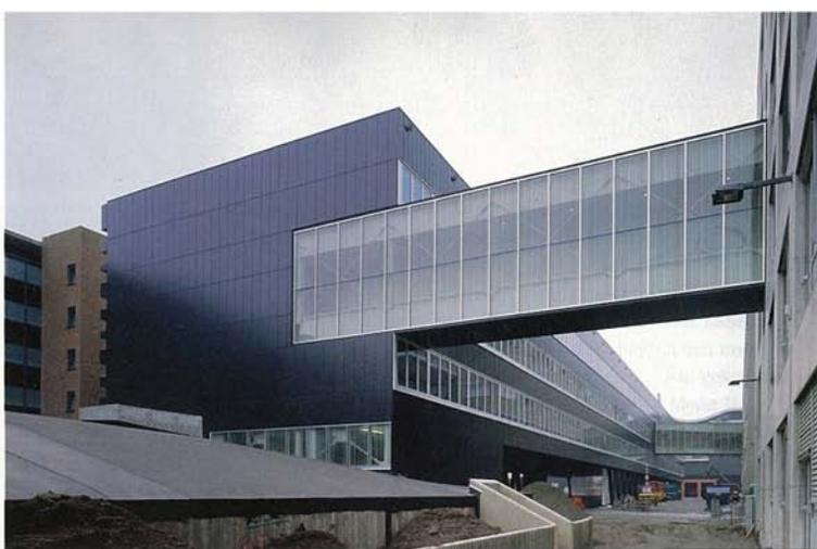
Der aufgeständerte Riegelbau besitzt keinen Eingang, die beiden Brücken zum Altbau wurden entsprechend betont: als wuchtige, einseitig verglaste Blechhülsen. Sie überqueren die Anlieferungszone des Chassé-Theaters und die Einfahrt in die Tiefgarage.
