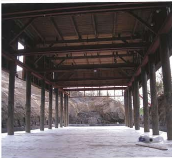
De kelder onder de wapenloods is volledig geïsoleerd. De stalen buispalen zijn in de keldervloer verankerd.
