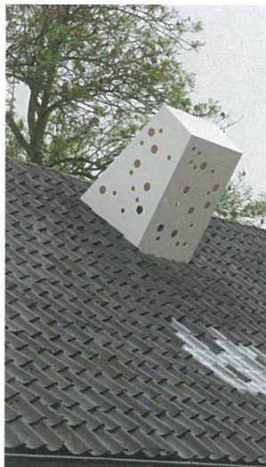
Op één moment is de uitbreiding van de wapenloods aan de buitenkant zichtbaar. Daar steekt het witte huisje met een zogenoemde geperforeerde schoorsteen door het dak.
