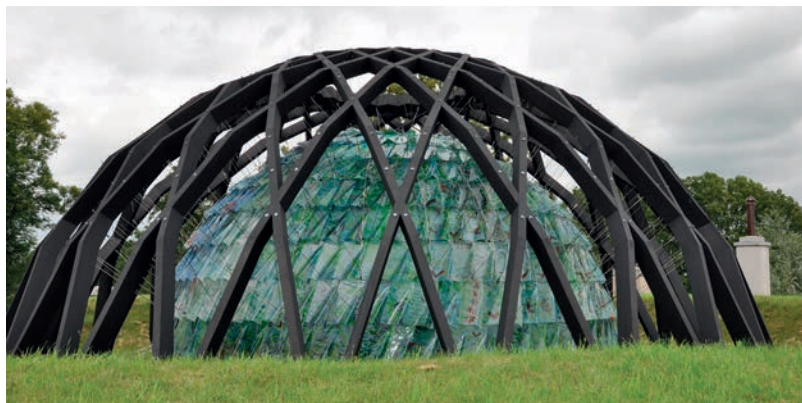
De glazen koepel is opgehangen aan een zware houten constructie, die in een betonnen ringbalk is verankerd.
