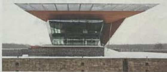
7. Bedieningsgebouw Volkerak sluisen in Willemstad. Foto Christian Richters
